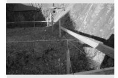
Das Schnurgerüst ein Hilfsmittel des Baumeisters. Es definiert den Standort und die Ausrichtung eines Gebäudes.
